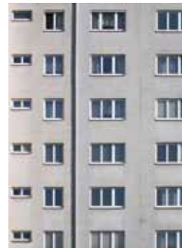
Wohnhausanlage Siebenbürgerstraße, 1962-1964 Oskar und Peter Payer Kein Denkmalschutz
